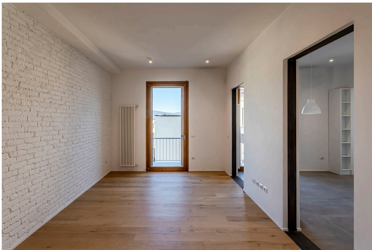
Figura 10 Come si presentano le cerchiature alla fine dei lavori
